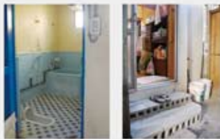
以前使っていたトイレと浴室（左写真）。大きな段差のある勝手口（右写真）から行き来していた
