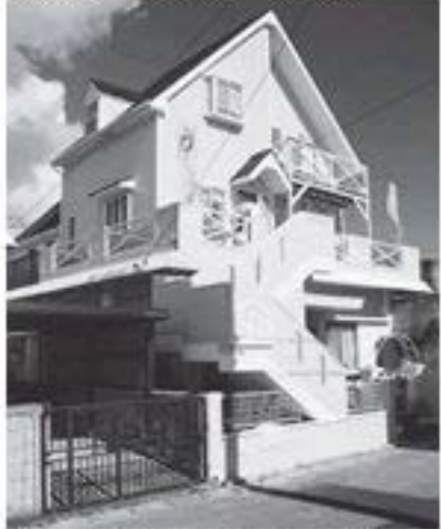
築二十年くらいのRC住宅の上に、2×4で増築。RCと木造のユニークなコンビネーション住宅ができた
